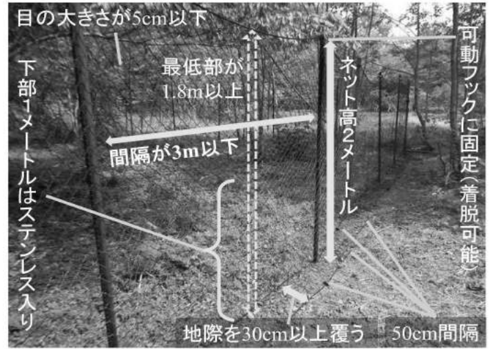
図5 AF規格準拠の防護柵の構造
