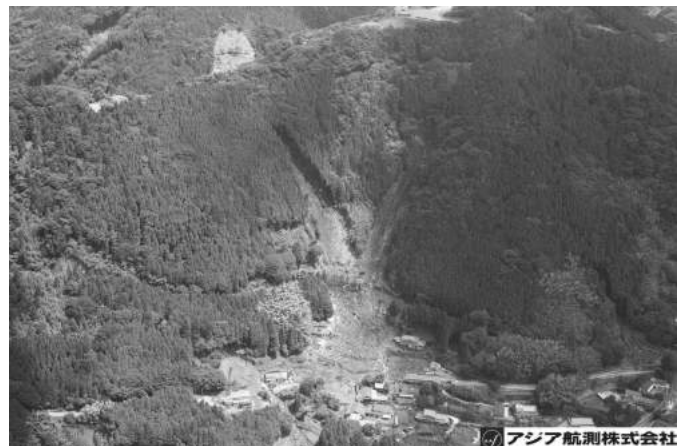
H29.7月 九州北部豪雨でも多くの人工林が崩れた
